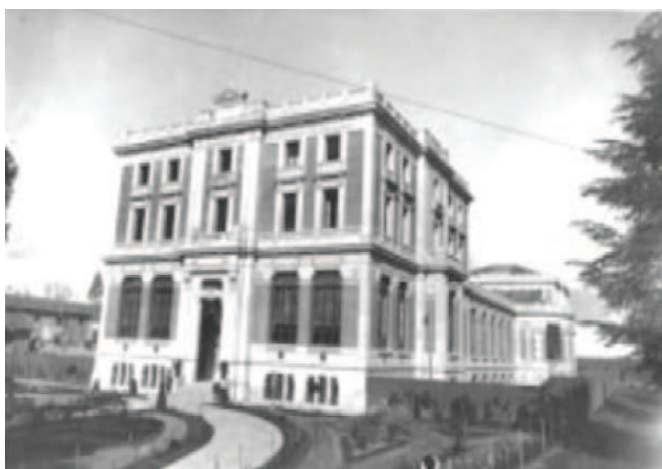
Pabellón central de la nueva ETSI Agrónomos, finalizado en 1925 (Archivo ETSI Agrónomos).
