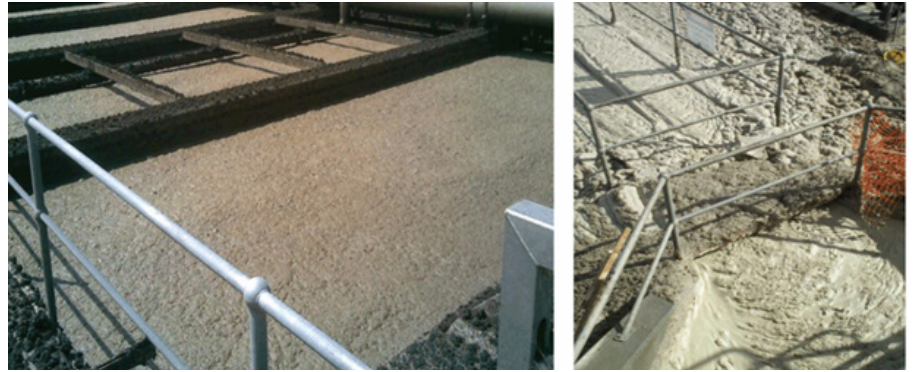
Fig. 1.- Espuma bacteriana extrema en una planta depuradora de aguas residuales.
